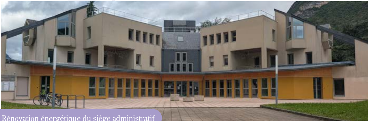
Rénovation énergétique du siège administratif
