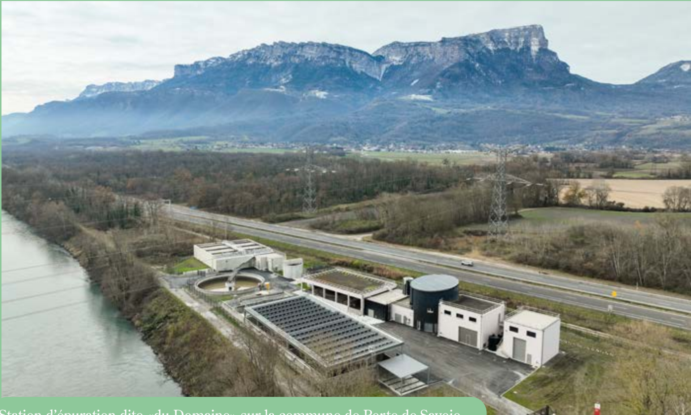
Station d'épuration dite «du Domaine» sur la commune de Porte-de-Savoie
