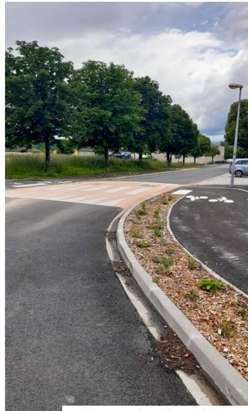
Aménagements sur la zone d'activités de Carouge
