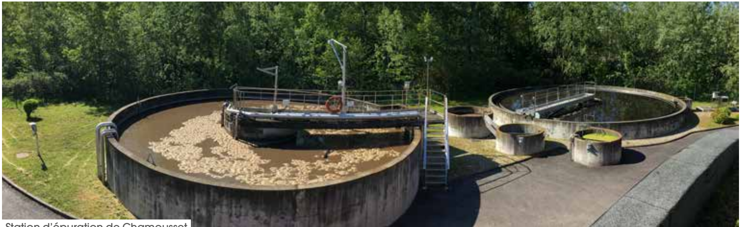
Station d'épuration de Chamousset
