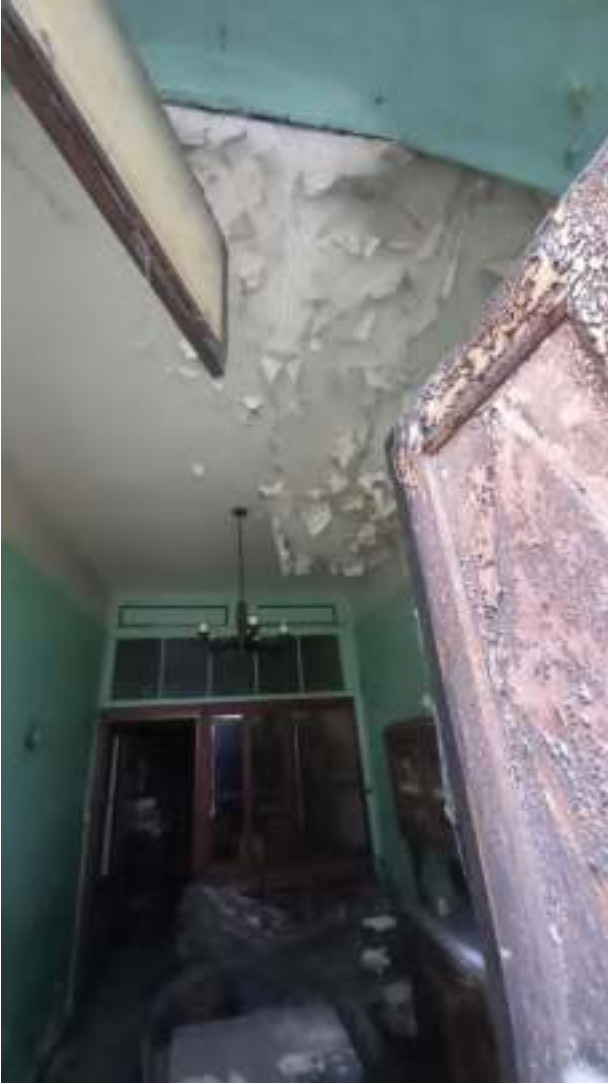
Plafond du séjour : fissures et signes d'affaissements inquiétants.
