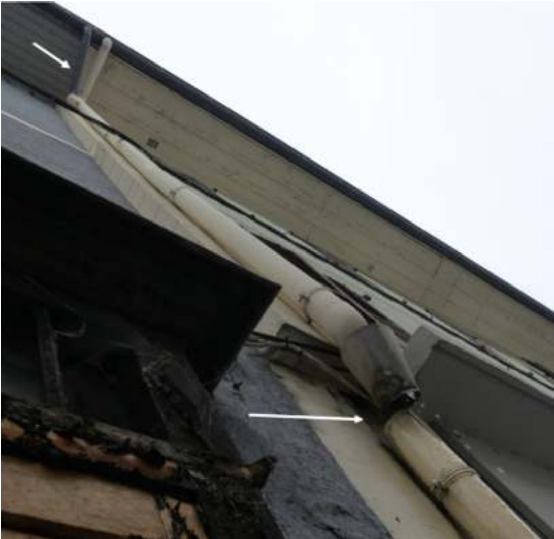
La descente commune disjointe
