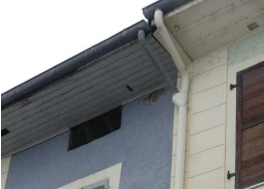
La descente collecte les eaux pluviales des deux bâtiments
