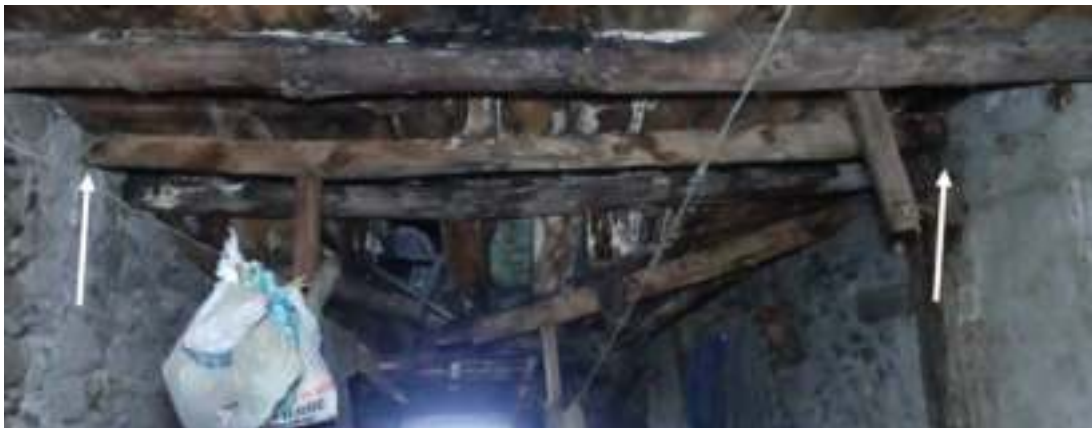
Pannes scellées de mur à mur
