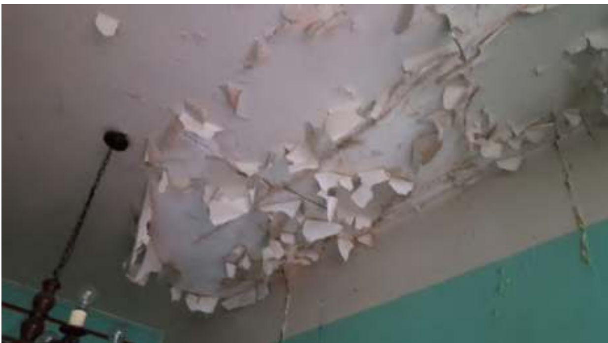
Plafond du séjour : fissures et signes d'affaissements inquiétants.
