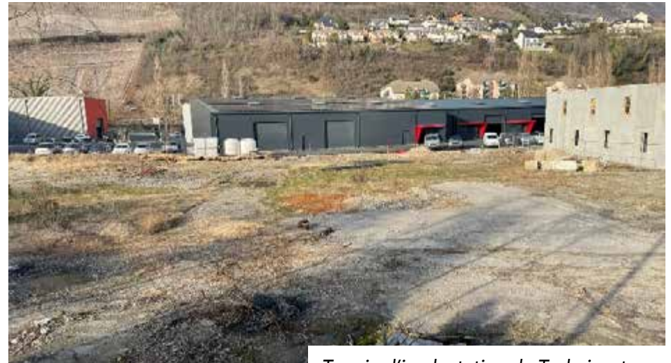
Terrain d'implantation du Technicentre
