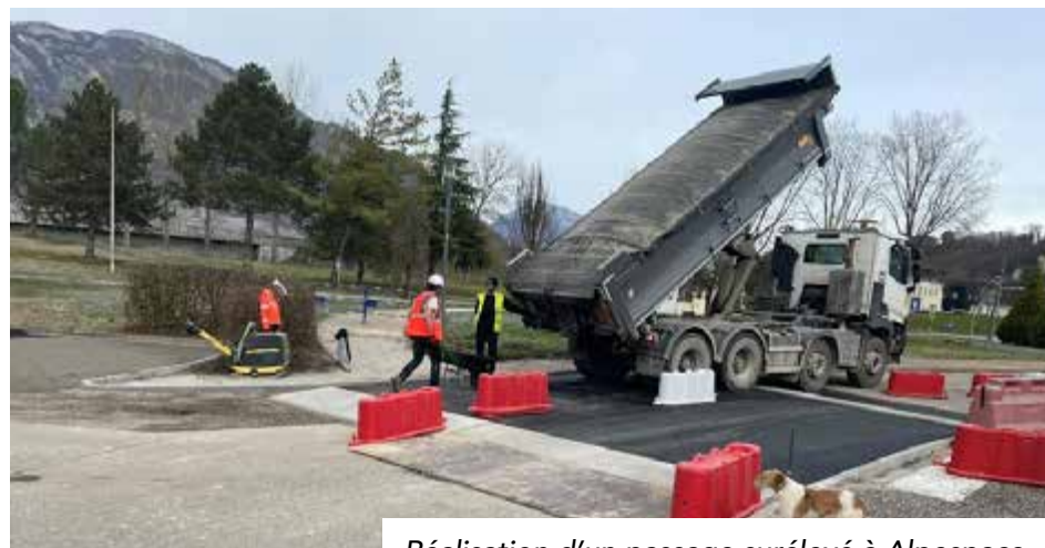
Réalisation d'un passage surélevé à Alpespace
