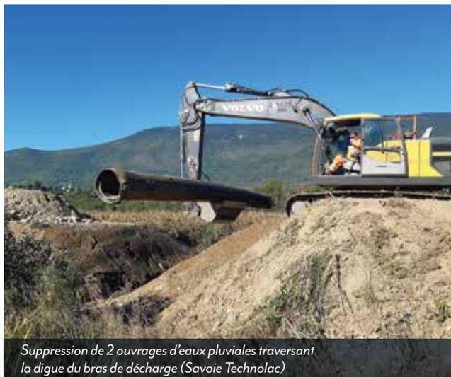
Suppression de 2 ouvrages d'eaux pluviales traversant la digue du bras de décharge (Savoie Technolac)
