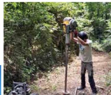
Sondage géotechnique dans une digue de la Leyse
