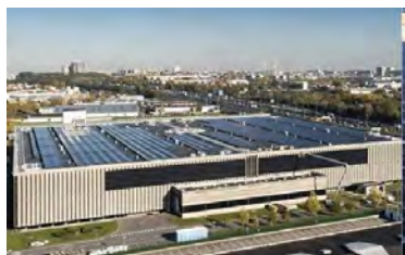
Sur membrane d'étanchéité bitumineuse
