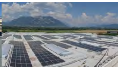
Sur membrane d'étanchéité PVC
